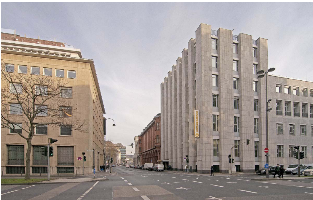
Building ensemble Tunisstrasse / Unter Sachsenhausen © Greif & Contzen 2019
