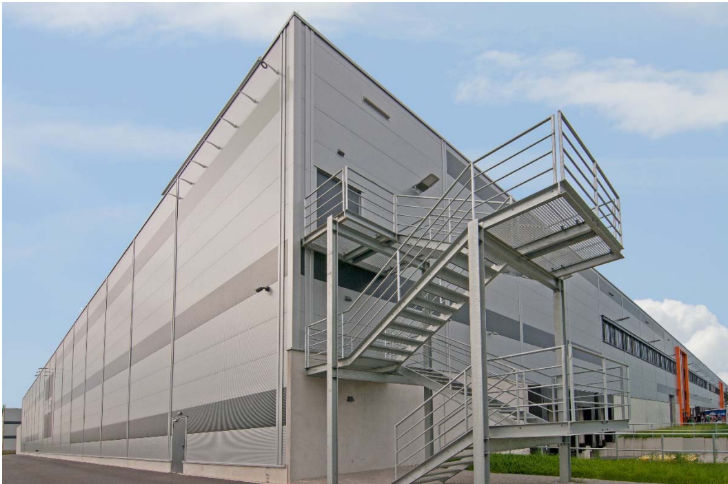
Neubauobjekt in Wesseling © Greif & Contzen 2017
