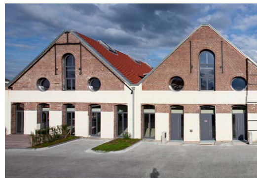
Kupferhütte im Carlswerk © BEOS
