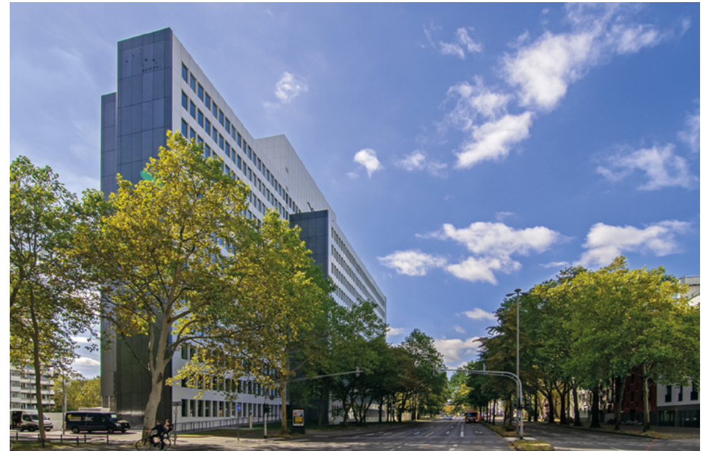
Die Revitalisierung des ONE Cologne an der Ecke Venloer Straße/Innere Kanalstraße wurde 2019 fertiggestellt
