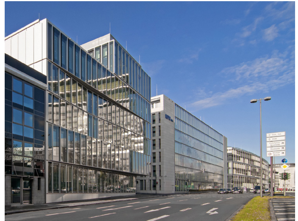
Die Bürogebäude der DEG und das Cäcilium an der Neuköllner Straße
