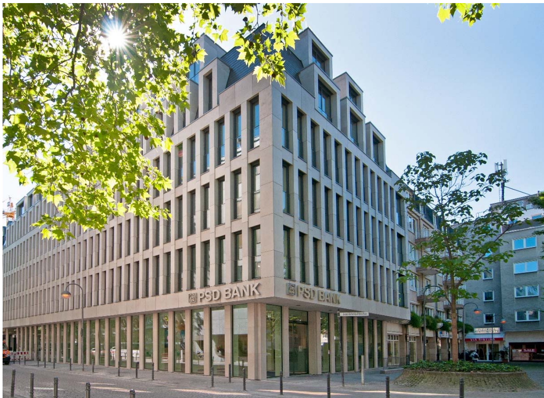
PSD-Gebäude: Revitalisiert mit Dachausbau zur Eigennutzung in Nachbarschaft zum Entwicklungsprojekt „Laurenz Carré“ © Greif & Contzen 2019
