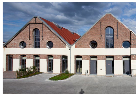
Kupferhütte im Carlswerk © BEOS
