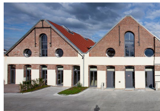
Kupferhütte im Carlswerk © BEOS
